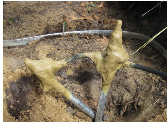
Bild 1 Angebrachte Korrosionsschutzbinde formschlüssig um Klemmverbindung im Erdreich
