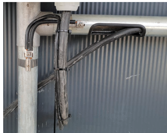
Bild 5 Potentialausgleich von metallenen Konstruktionsteilen mittels blitzstromgeprüften Bandrohrschellen
